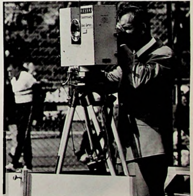
Elektronische worpafstandmeter van Zeiss voor kogelstoten, speer- en diskuswerpen.
